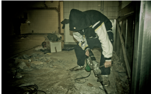
Den gamle guttedoen rives ned.
