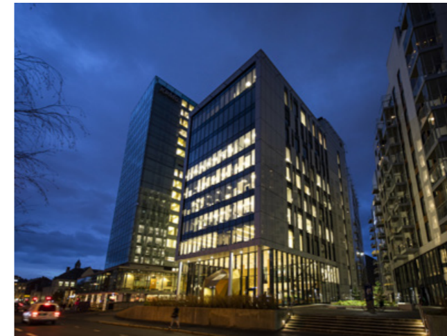
I Sørkedalsveien 8, Oslo, har det blitt montert to nye elbilladere, og det er bestilt ny eltavle som vil muliggjøre installasjon av flere ladere.
