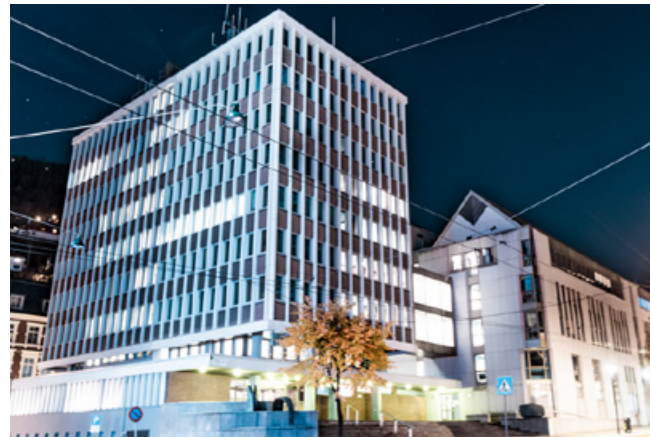
Allehelgensgate 6, Bergen. Foto: Entra
